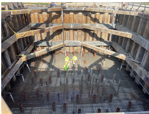
(a) Armering inför gjutning av platta.
