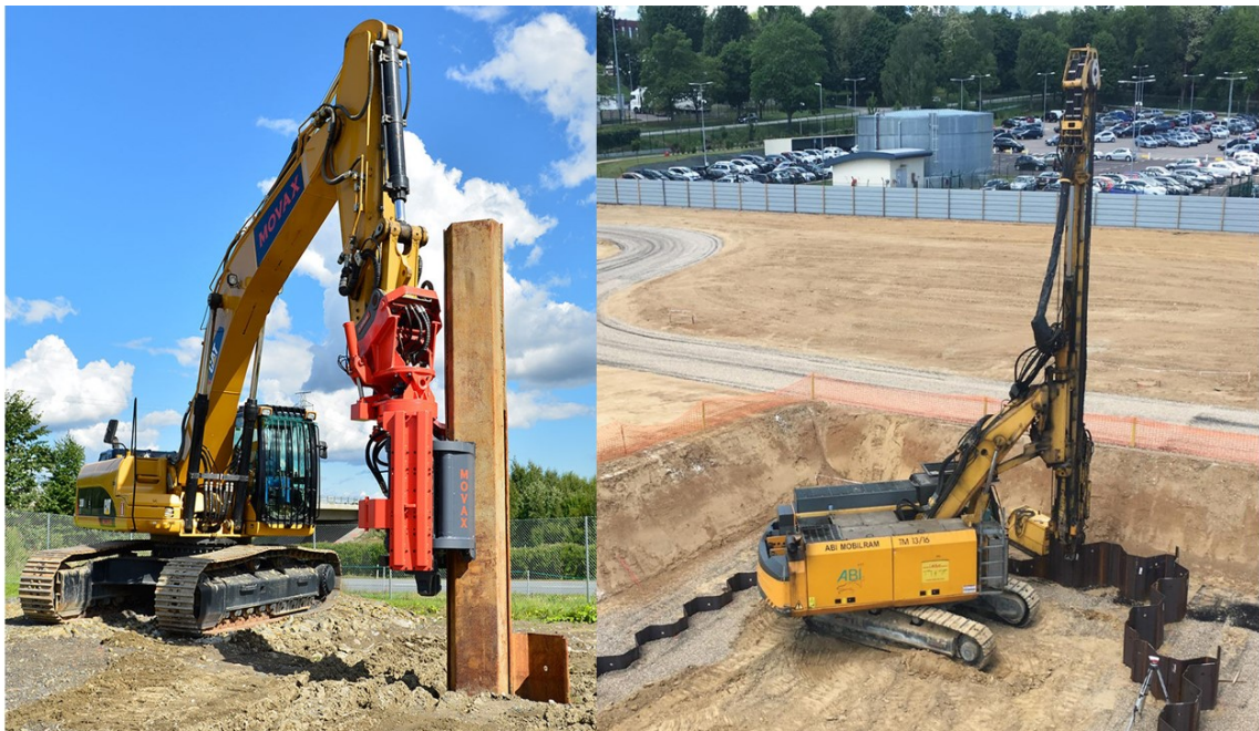
Figur 2.1: Två metoder för drivning av spont, vibrering till vänster och slagning till höger.
