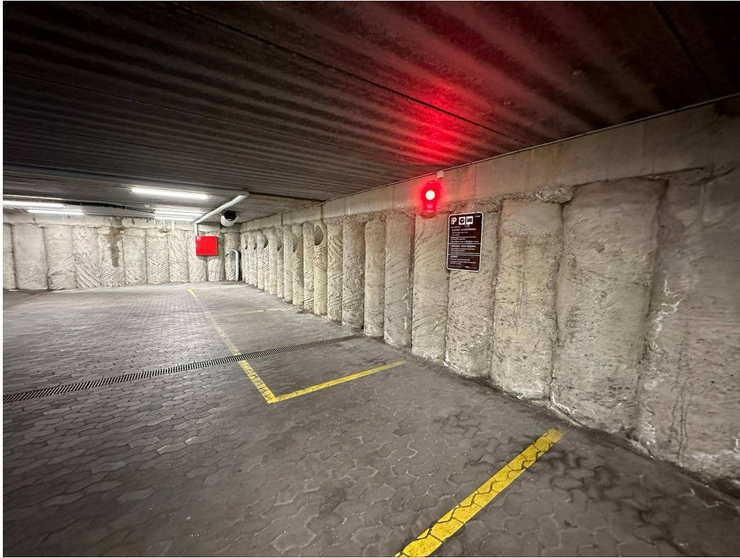
Figur 2.6: Råa sekantpåleväggar från ett P-garage i Köpenhamn, notera dagvattenlösningen med rännan. Foto: Edward Marks
