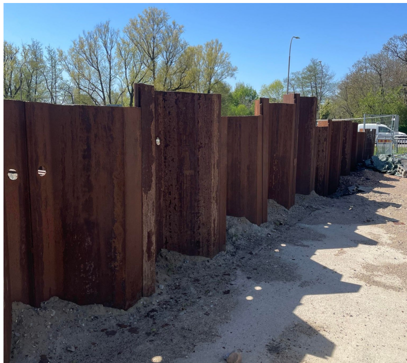
Figur 2.1: Temporära spontplank intill en trafikerad väg från ett grundläggningsprojekt i Lund. Foto: Edward Marks.
