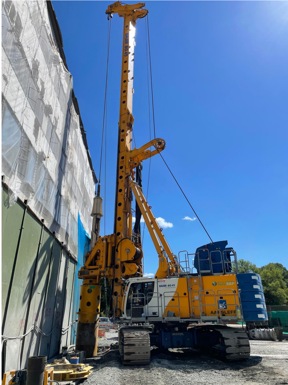
Figur 2.2: En bild från Haga i Göteborg där grävpålar tillverkades med Kelly-borring. Maskinen är en Bauer BG45. Foto: Edward Marks.
