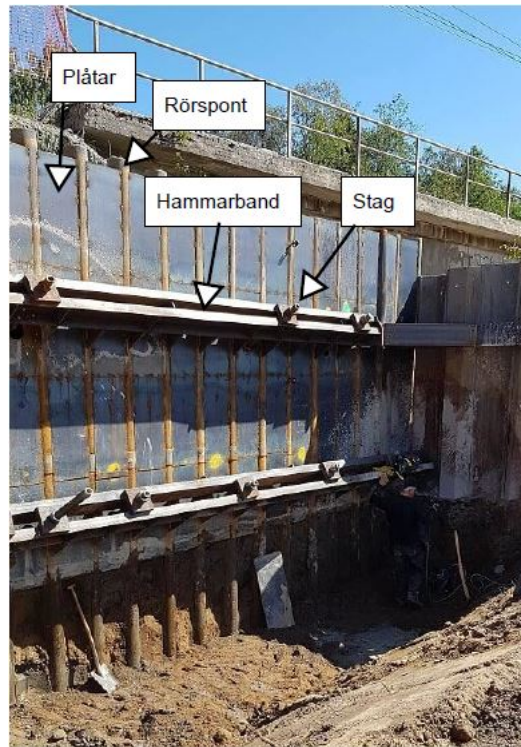
Figur 2.1: Beskrivning av spontens olika delar
