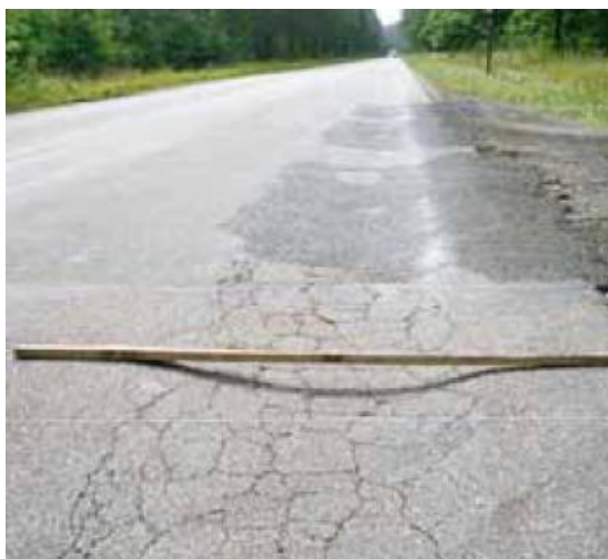
Figur 7-3: Spårbildning uppstår på grund av brist på bärighet hos materiallager (ROADDEX III, 2003)
