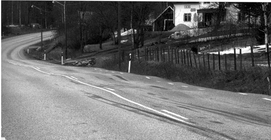
Figur 7-9: Ojämnheter i vägen (VTI & Vägverket, 2003)
