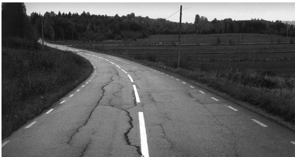
Figur 7-7: Tjälspäckor som är vanligt förekommande under kalla tider (VTI & Vägverket, 2003)
