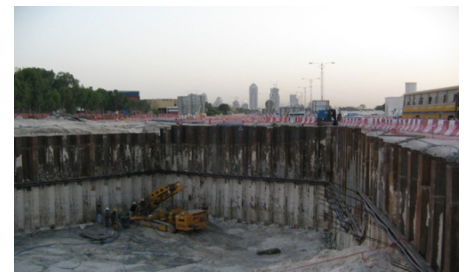
Sheet Piling Schakt (Bild från Bumi)
