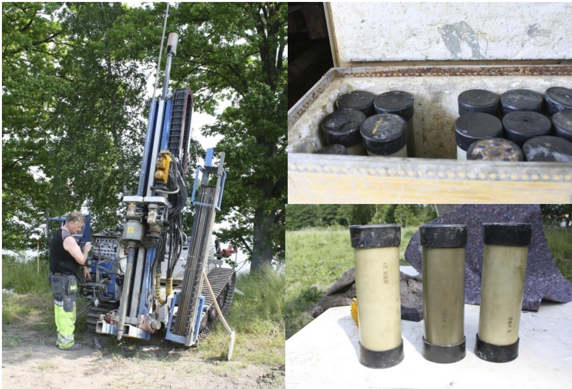
Figur 20. Kolvprovtagning med kolvprovtagare.
