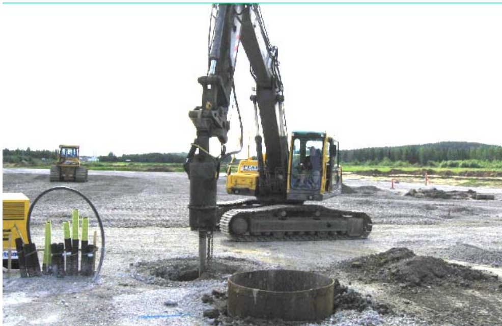
Figur 2.3 Tillverkning av grävålar där borrhålet stabiliseras med foderrör. Lägg märke till storleken på bormaskinen som kan nå upp till ca tio meters djup. (Peab Grundläggning 2010)
