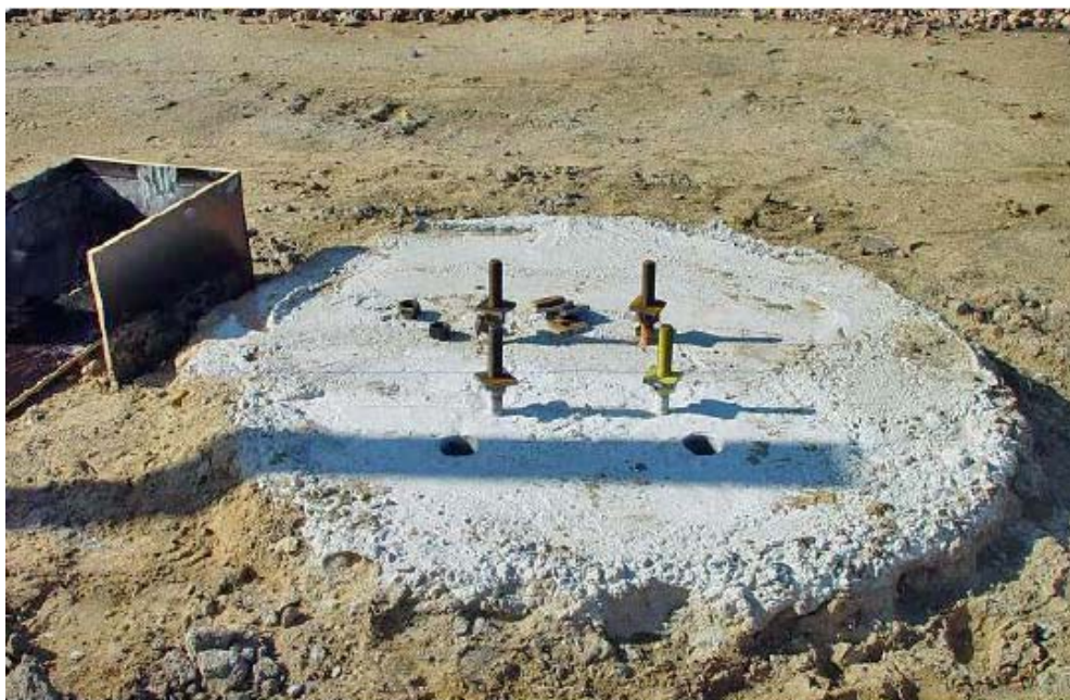
Figur 2.4 Färdig grävåle med förtagningsjärn för montering av stommen (ByggAi 2010)
