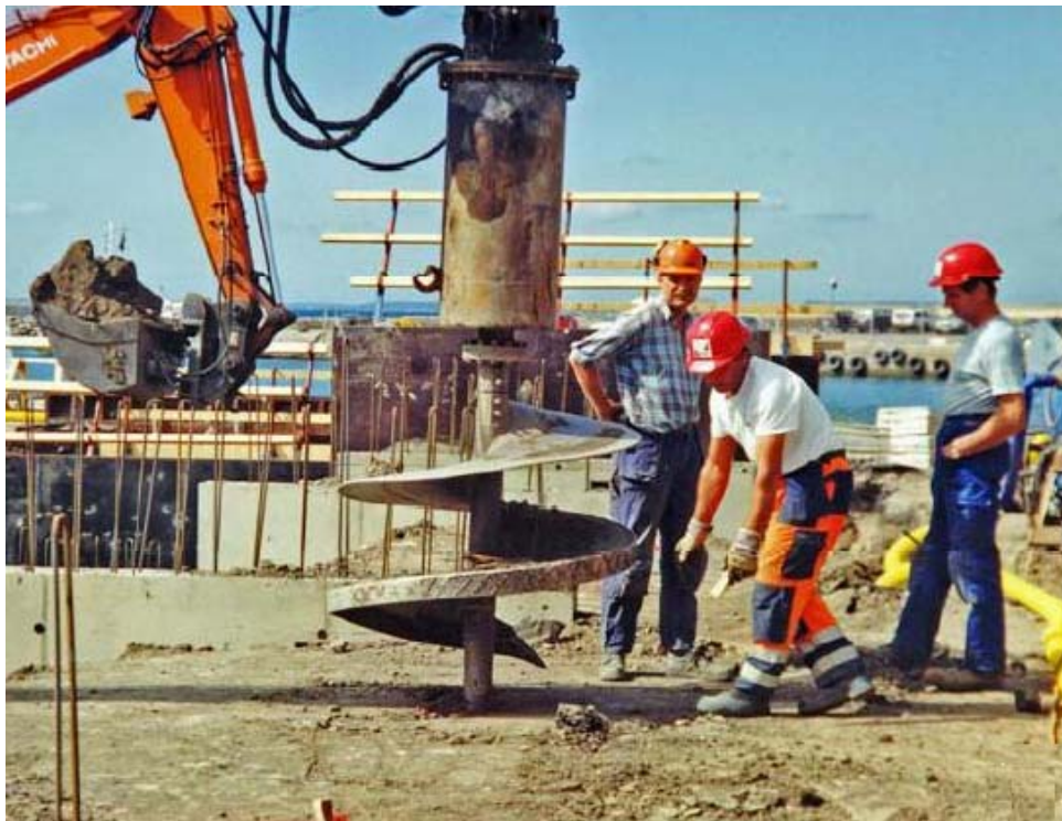
Figur 2.2 Borrhning av grävpålar med jordskruv (ByggAi 2010)
